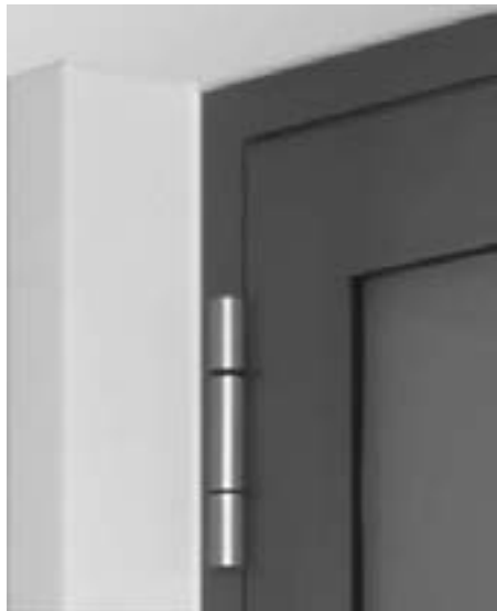
Rollentürband eingebaut Installed barrel hinge
